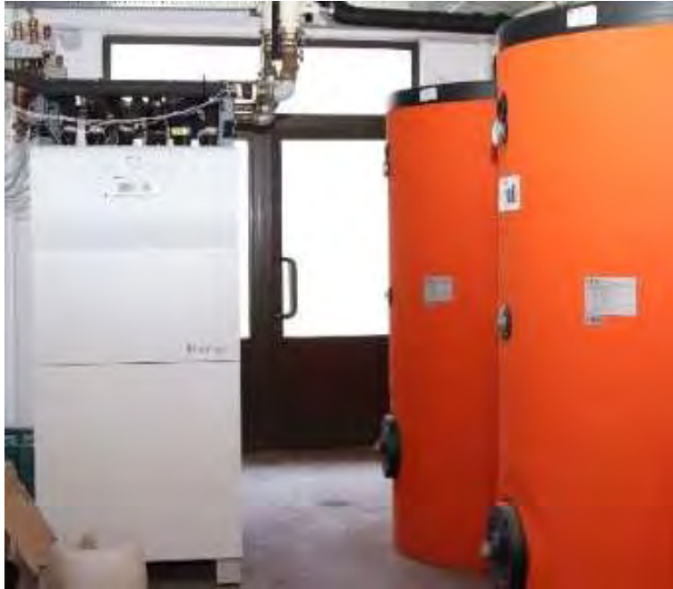
Figura Error! No text of specified style in document..9 – Răcitor cu adsorbție cuplat la sursă de cald
