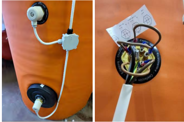
Figura Error! No text of specified style in document. 26 - Montaj rezistențe pe boiler
