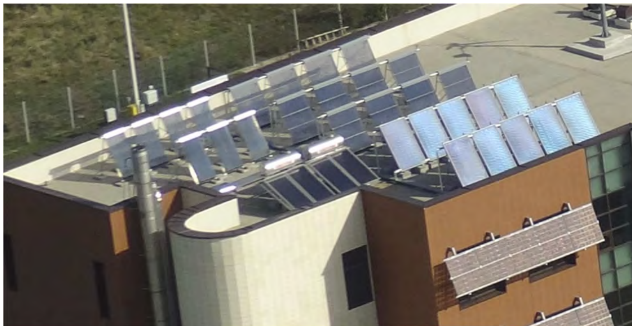
Figura Error! No text of specified style in document..12 – Platforma experimentală termosolară ICSTM
