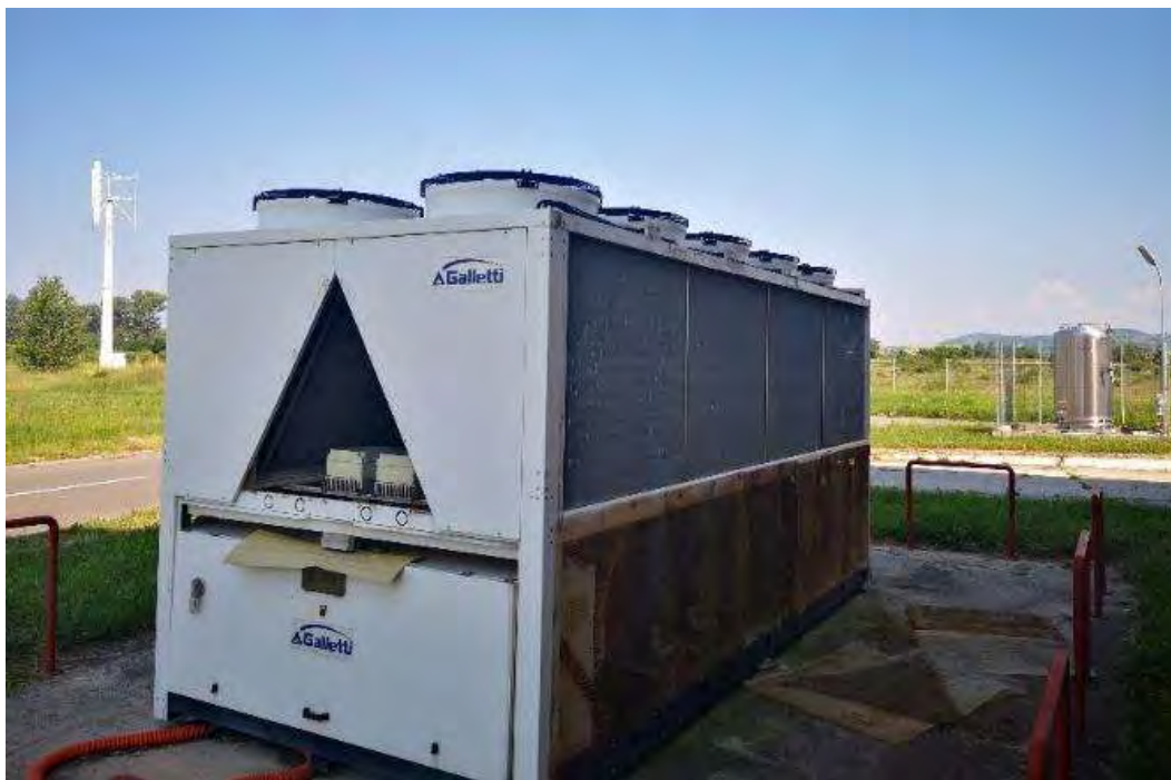
Figura Error! No text of specified style in document..8 - Pompă de căldură aer-apă Galletti
