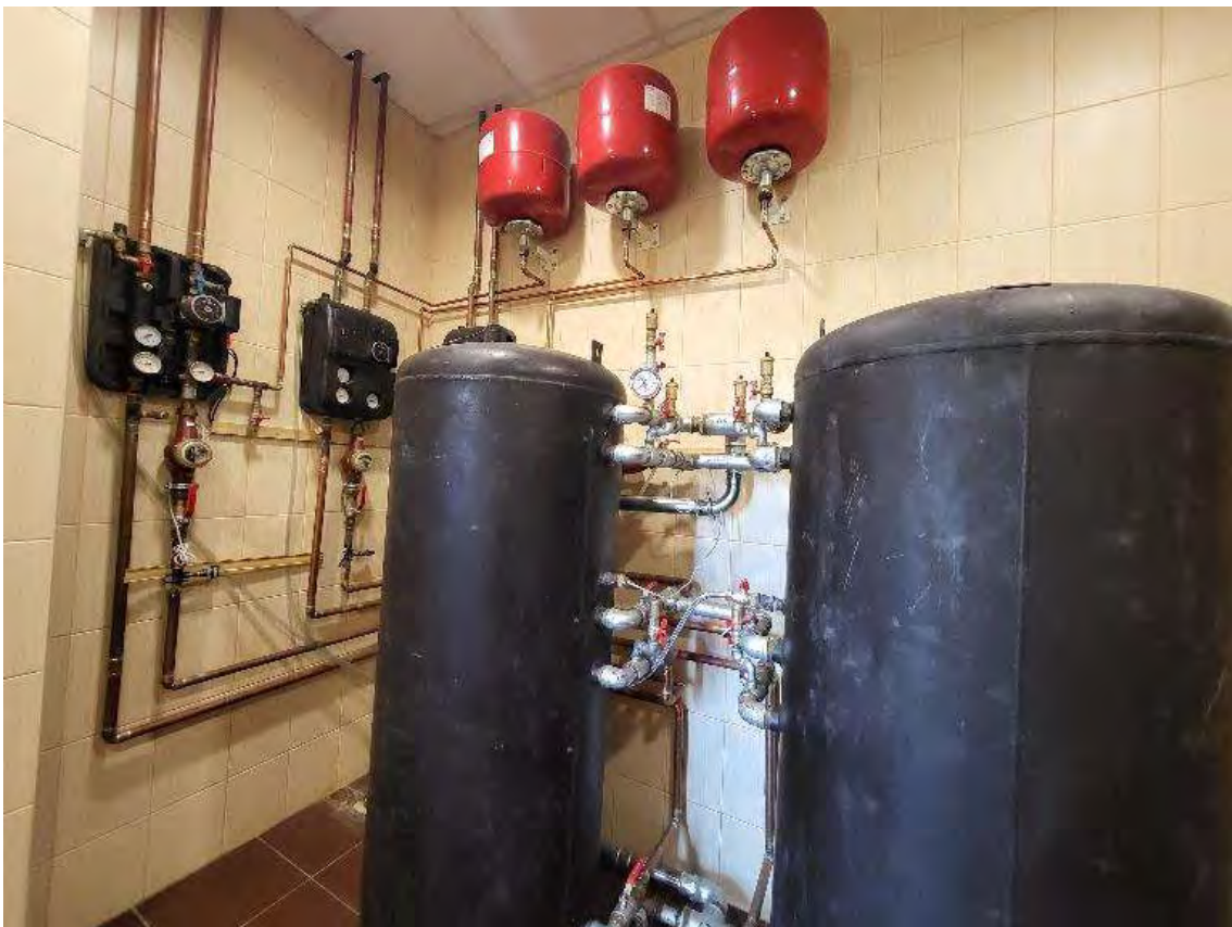
Figura Error! No text of specified style in document..20 – Spațiu amenajat pentru noua instalație termosolară
